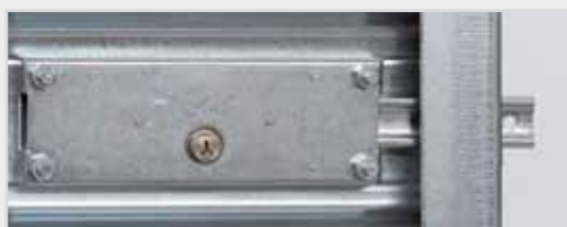
PARTICOLARE DELLA SERRATURA LATERALE
